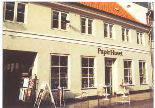
Butiksvinduerne følger samme takt som vinduerne på 1. sal, hvilket giver en rolig og harmonisk facade.
