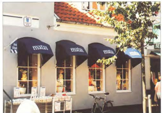
Er solafskærmning af en række smalle vinduer nødvendig, monteres en udslagsmarkise over hvert af vinduerne.
