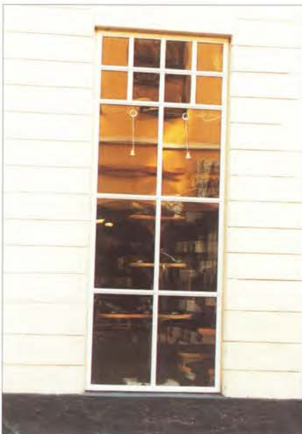
I dag laves butiksvinduerne af aluminium i stedet for støbejern, men mange af støbejernets kvaliteter er bevaret.
