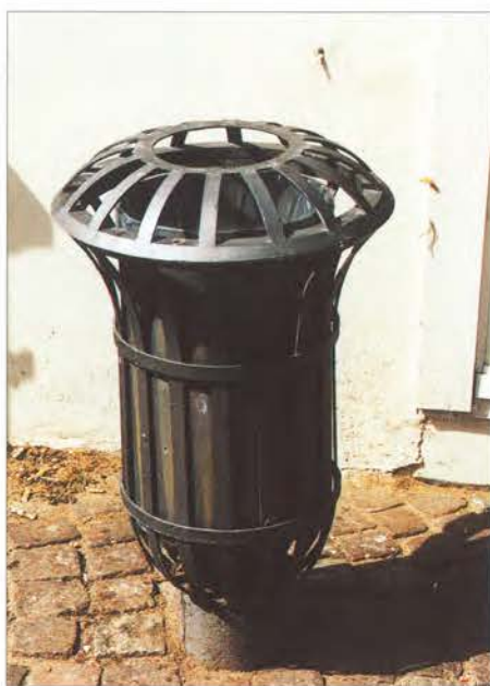
Den karakteristiske affaldskurv er bygget op af 2 mm båndjern.
